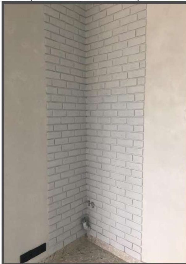
декоративная отделка стен санузла
